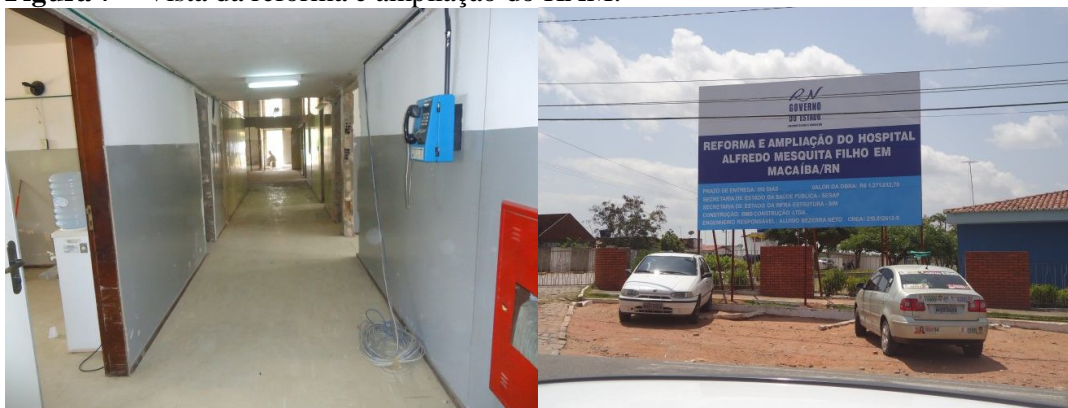
Figura 7 – Vista da reforma e ampliação do HAM.
