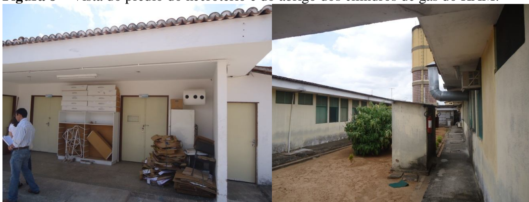
Figura 8 – Vista do prédio do necrotério e do abrigo dos cilindros de gás do HAM.
