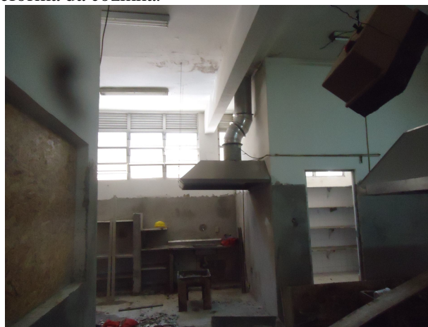
Figura 6 – Vista da reforma da cozinha.
