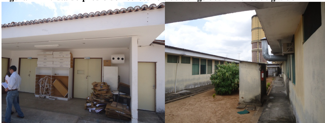
Figura 12 – Vista do prédio do necrotério e do abrigo dos cilindros de gás do HAM
